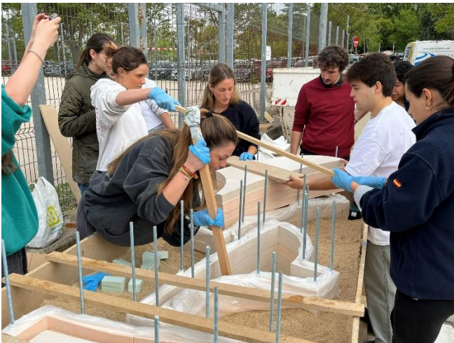
Trabajo de hormigonado en zona pistas
