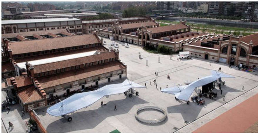
Vista área de Matadero, Madrid
