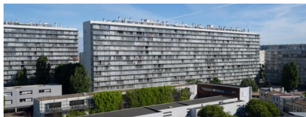
Lacaton & Vassal.: PLUS: 530 viviendas en Burdeos (Francia)
