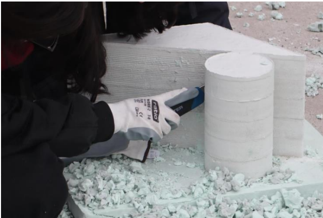
Trabajo de desencofrado en zona pistas
