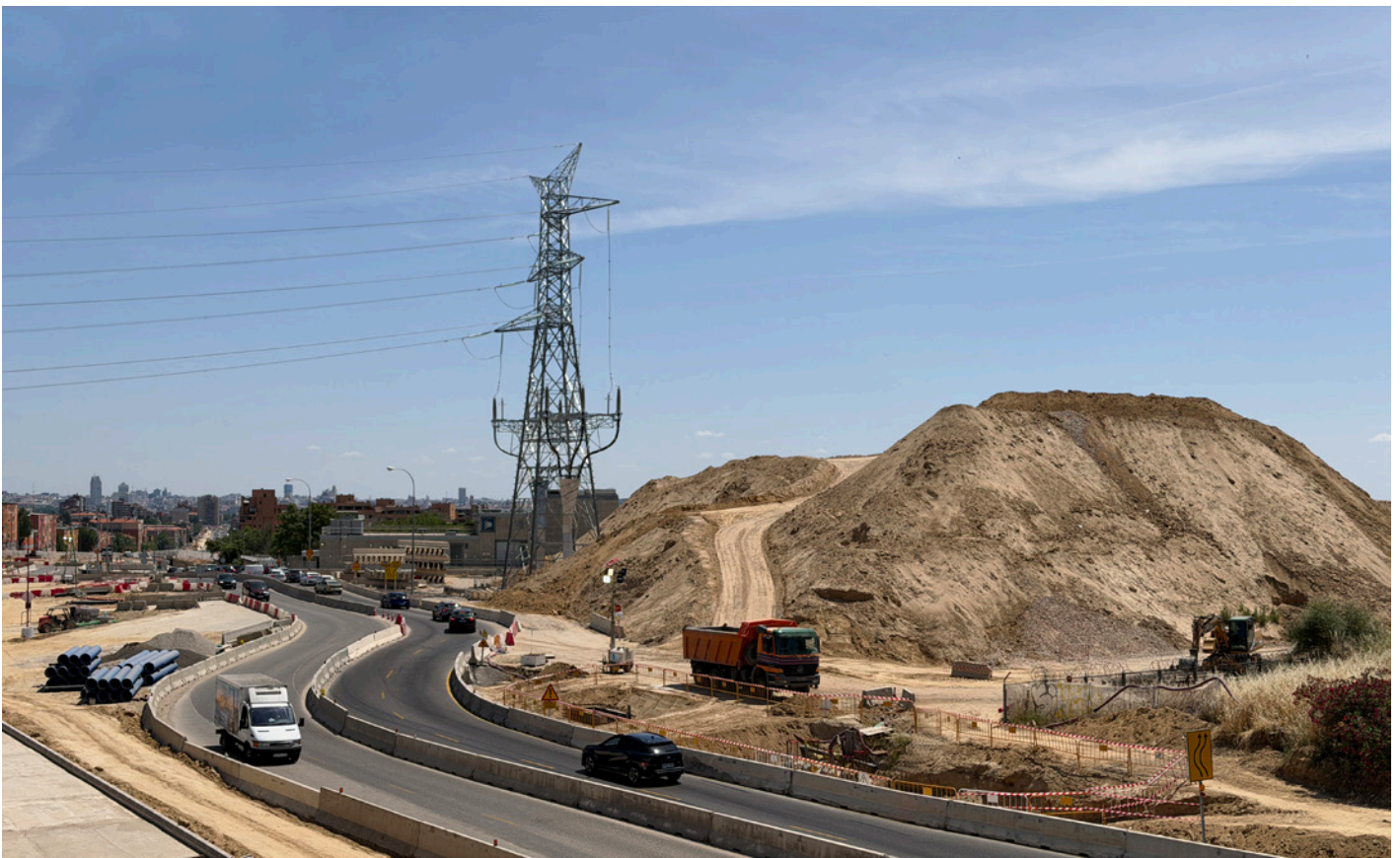
Vista de las obras de soterramiento de la A5 en Madrid, Junio de 2026
