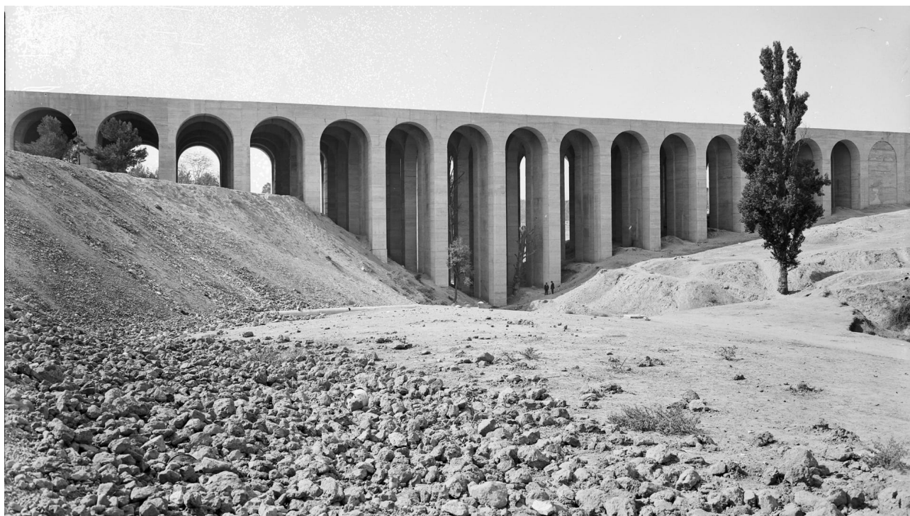
Eduardo Torroja, Viaducto de los Quince Ojos (1935) en la Ciudad Universitaria de Madrid
